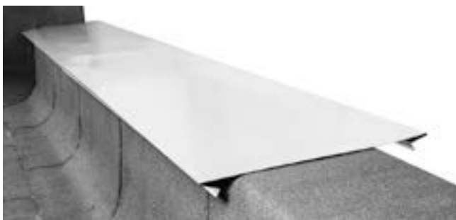
Рис. 3.29. Установка парапетной крышки
