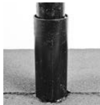
Рис. 3.33. Примыкание кровли к трубе
