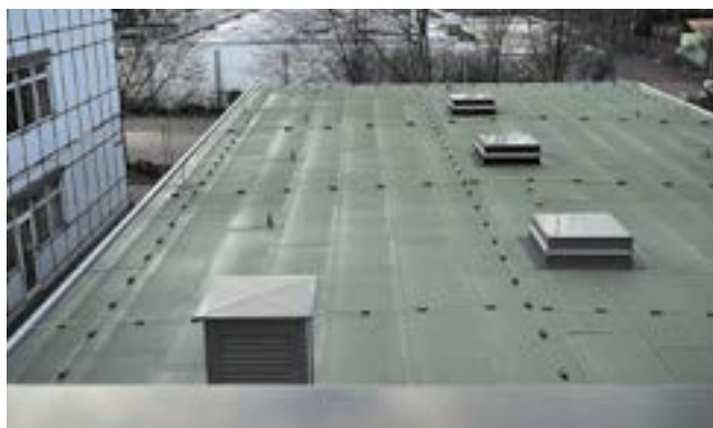
Рис. 3.56. Устройство молниеприемной сетки на кровле
