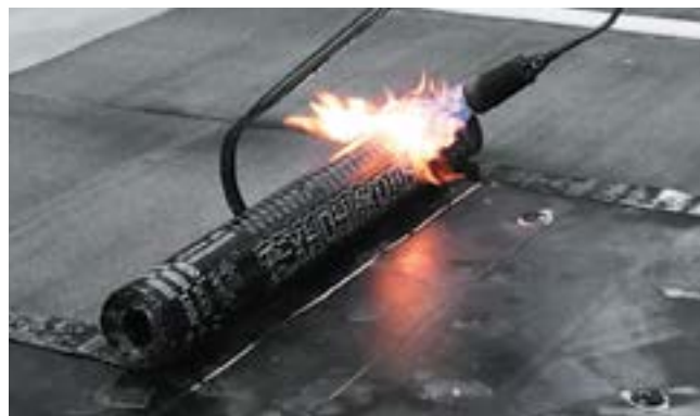
Рис. К.1. Наплавление по теплоизоляционным плитам
