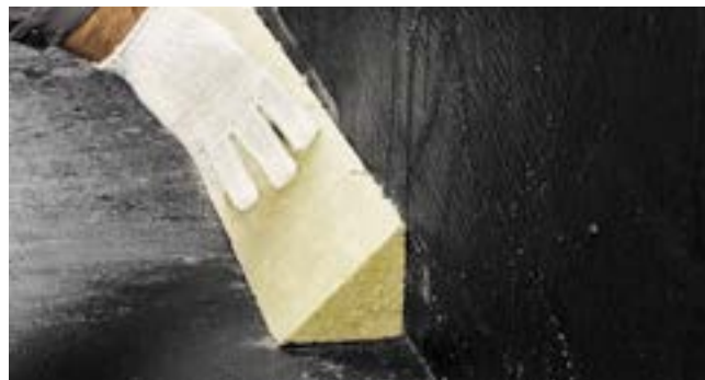
Рис. 3.13. Устройство наклонного бортика
