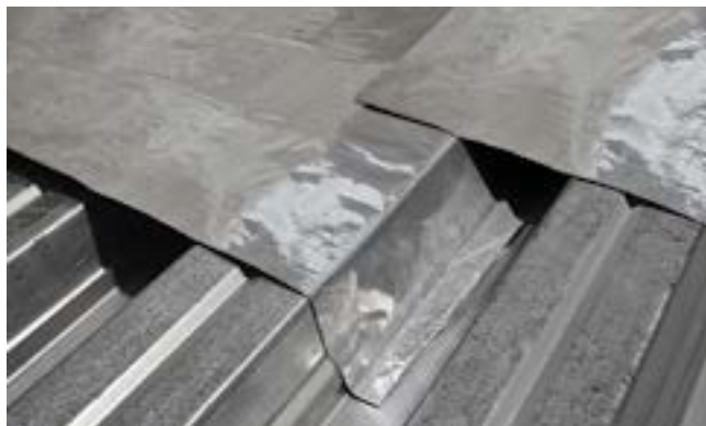
Рис. 3.6. Формирование продольного нахлеста пароизоляции на профлисте
