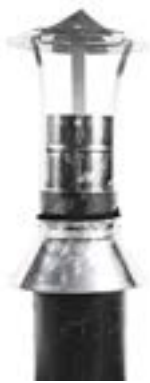
Рис. 3.34. Устройство защитного фартука на трубе
