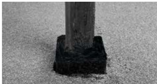
Рис. 3.37. Примыкание кровли к трубам малого диаметра
