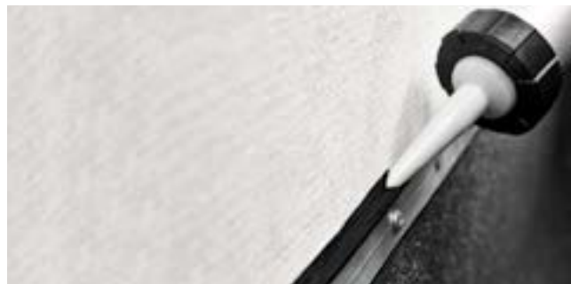
Рис. 3.24. Герметизация края краевой рейки
