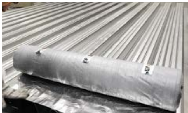
Рис. 3.5. Укладка пароизоляционного материала по профлисту
