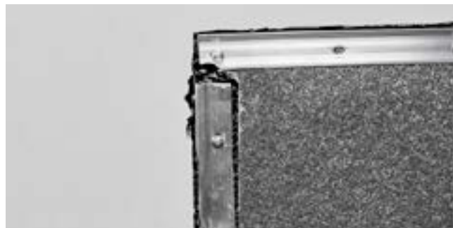
Рис. 3.23. Обрамление края кровельного ковра краевой рейки
