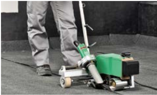
Рис. 3.45. Сварка шва автоматическим оборудованием
