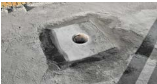
Рис. 3.12. Локальное понижение в месте установки воронки
