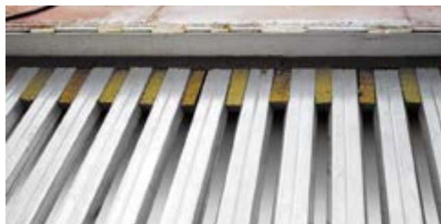
Рис. 3.1. Заполнение пустот ребер профнастила минераловатным утеплителем в местах примыкания
