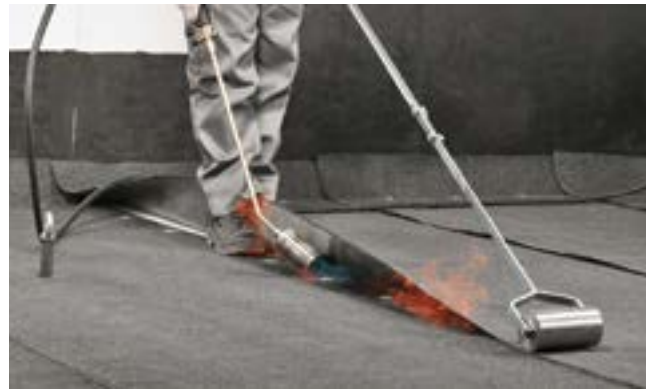
Рис. 3.46. Сварка шва с использованием газовой горелки
